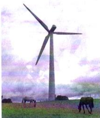
L'éolienne de Charrat (VS) est la plus grande de Suisse.
